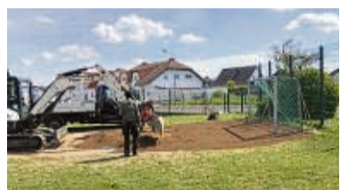
Arbeiter bringen den neuen Bodenbelag auf. FOTO: STADT
